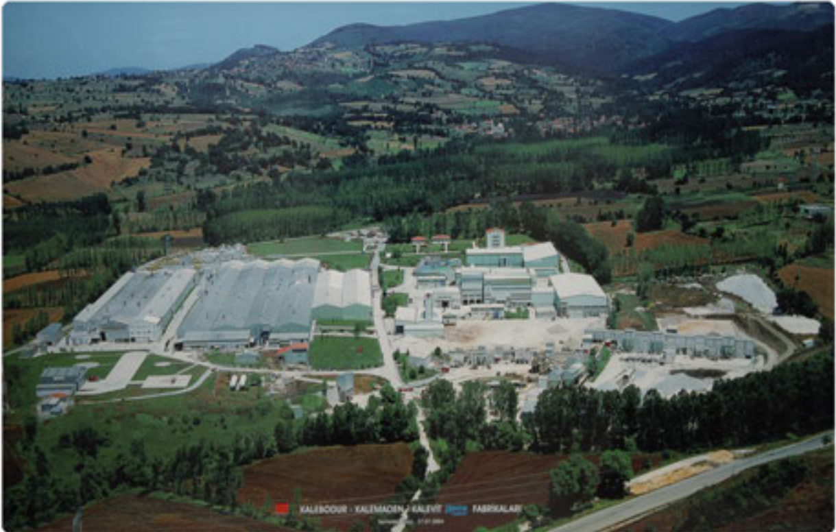
Kale Grubu Sıradan Tesisi
